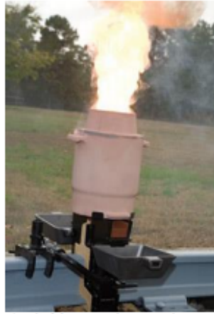
Figura 1 - Soldagem aluminotérmica [4]
