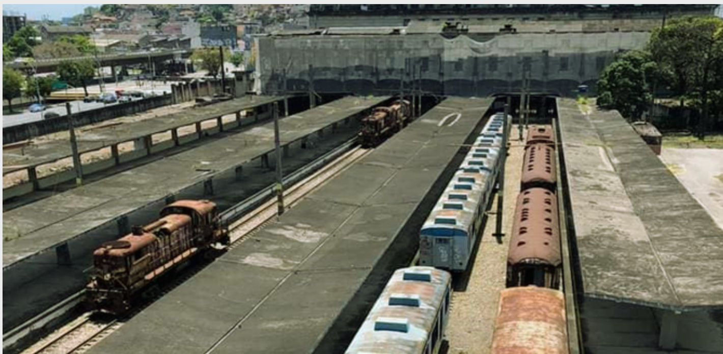
Figura 4 – Plataforma abandonada da Estação Barão de Mauá da Estrada de Ferro Leopoldina no Rio de Janeiro. Fonte: Leopoldina Railway (2022).
