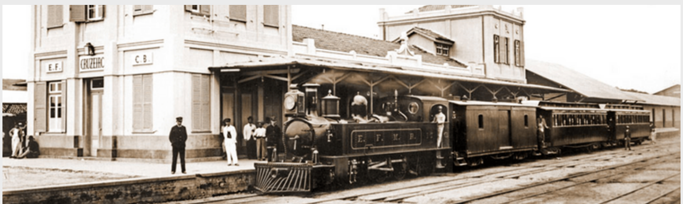
Figura 1 – Estação Ferroviária de Cruzeiro - RJ (EFCB). Fonte: Massa (2022)
