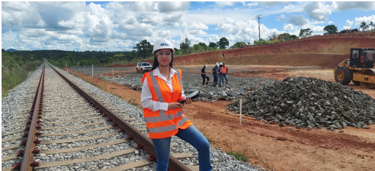
Foto 2: Engenheira Michelle realizando fiscalização de obra na FICO - Ferrovia de integração Centro Oeste com uso de Geotecnologias aliado ao GeoBIM.
