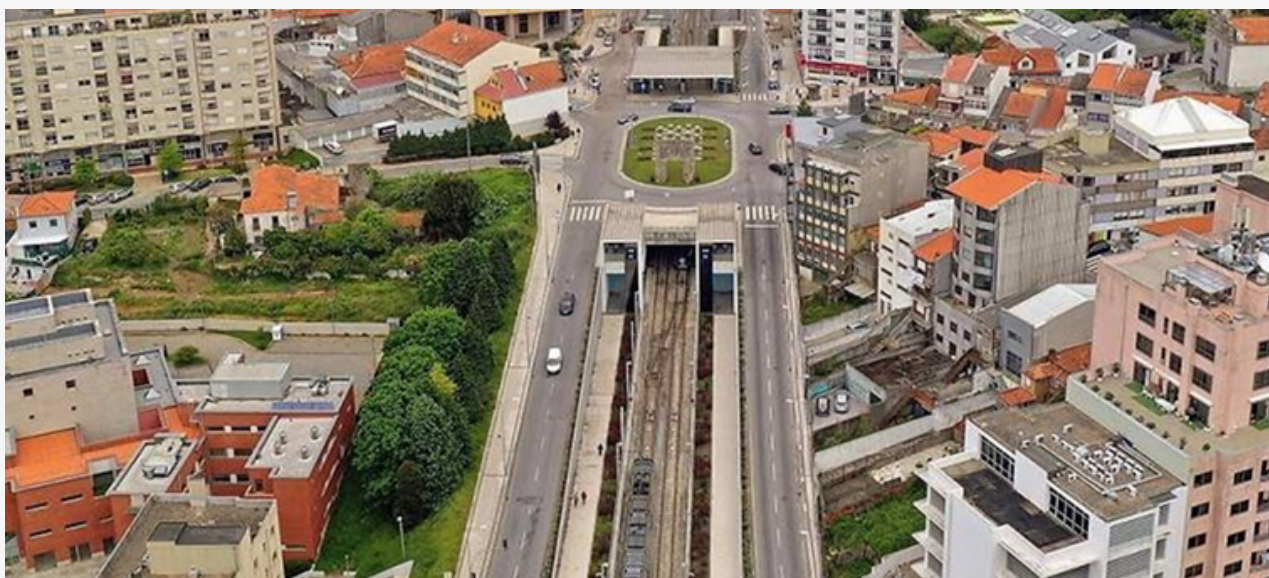
Figura 8 – Ferrovia de Alta Velocidade inserida em trecho de elevada densidade urbana.
